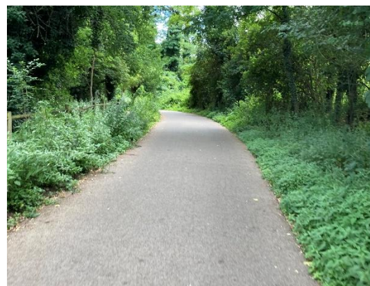
Figure 13 - Nouveau revêtement HQE mis en œuvre en 2019
