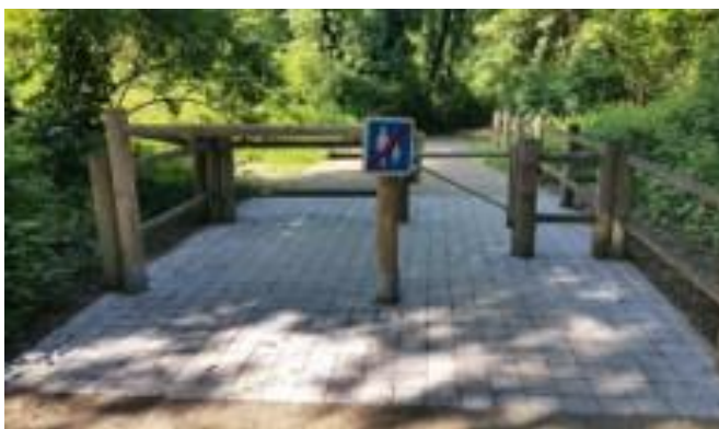
Figure 12 - Dispositifs de ralentissement et d'apaisement des circulations (dispositif à éviter car difficilement franchissable par certains vélos)
